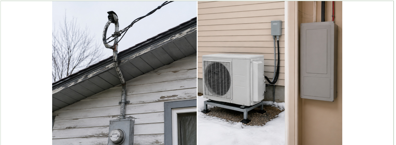
À gauche : entrée de service usée. À droite : thermopompe, sectionneur et panneau fermé.
