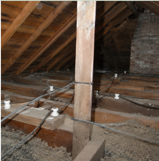
À gauche : câblage bouton-et-tube. À droite : câble d'aluminium débranché en cours de vérification.
