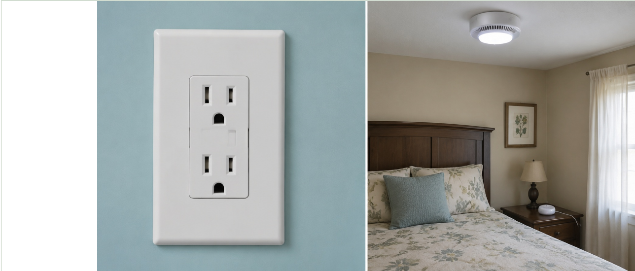
À gauche : prise inviolable. À droite : avertisseur et équipement d'alerte dans une chambre.
